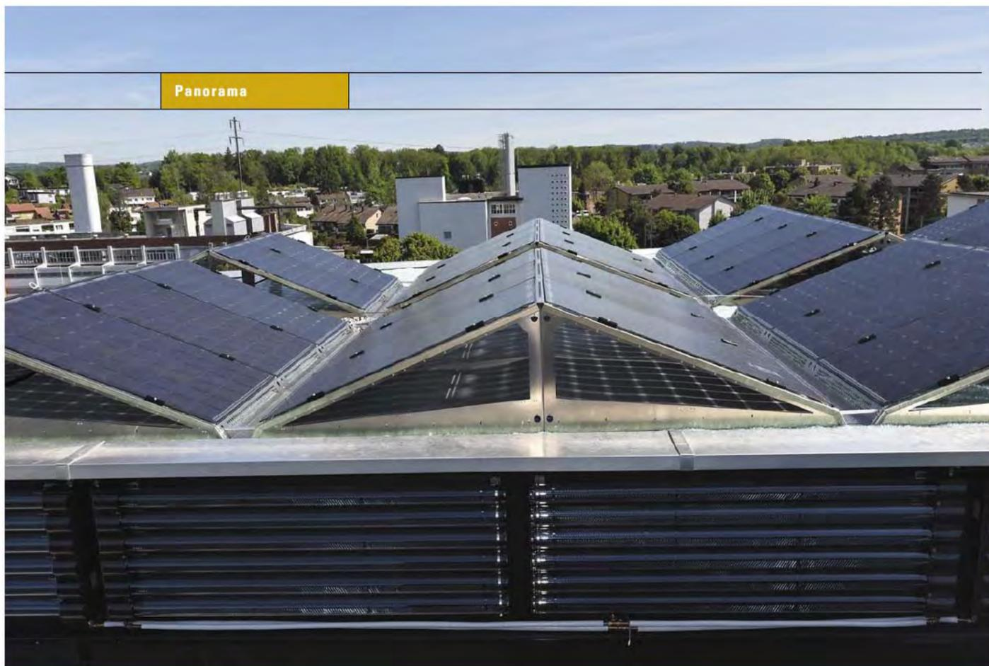
Flächennutzung: Im Prinzip ist Ost-West-Ausrichtung für bifaciale Module nicht optimal, ermöglicht aber eine vollständige Nutzung der verfügbaren Dachfläche
