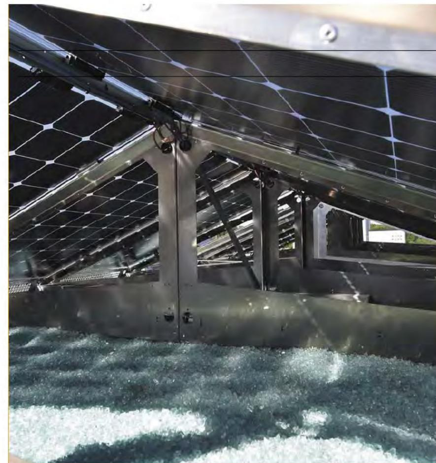
Das Foto zeigt die eigens entwickelte Unterkonstruktion: Sie muss zur optimalen Nutzung der bifacialen Module nicht nur an den Seiten möglichst viel Lichteinfall ermöglichen, sondern auch eine von Kabeln und Stützen freie Modulrückseite gewährleisten. Die Glaskörper auf dem Boden sorgen für verbesserte Reflexion.
